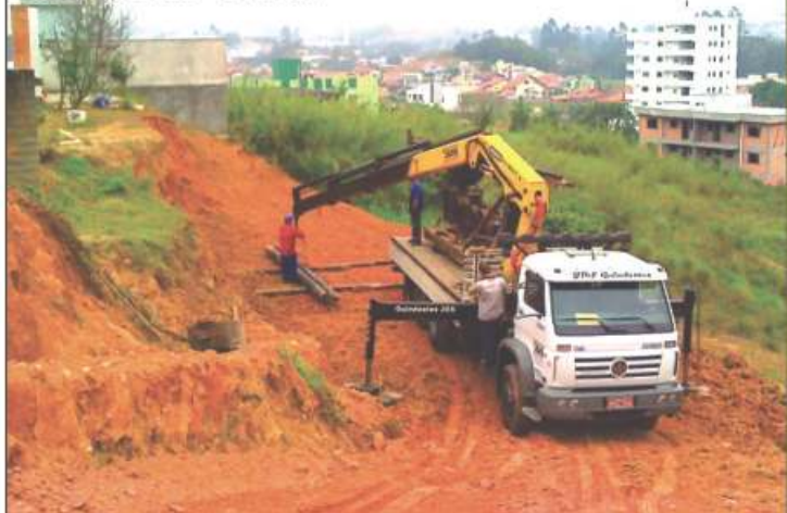
lçamento, transporte e montagem Bate-estacas - 4 ton's.
